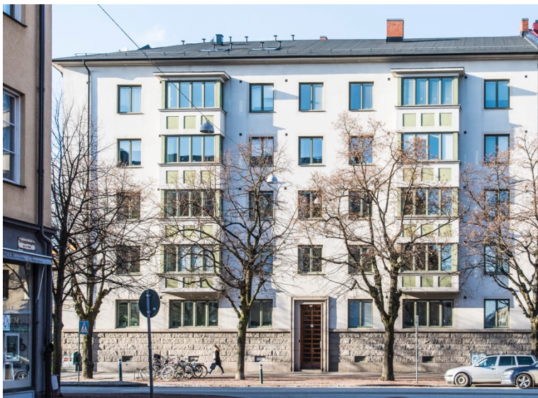
Figur 10-11. Fasad mot Regementsgatan och port mot Roslins väg. Klassicistisk fasad med burspråk, sockel av kvadersten och höga portar.
