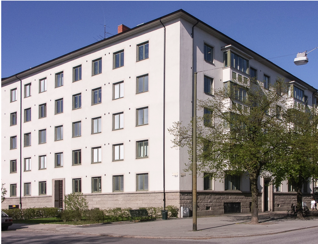
Figur 1. Fastigheten Regementsgatan 19 – Roslins väg 1, bostadsrättsföreningen Husaren 19.
