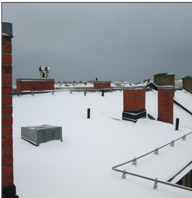
Taktäckning av papp
