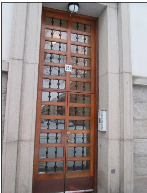
Större träportar av ek till trapphusen
