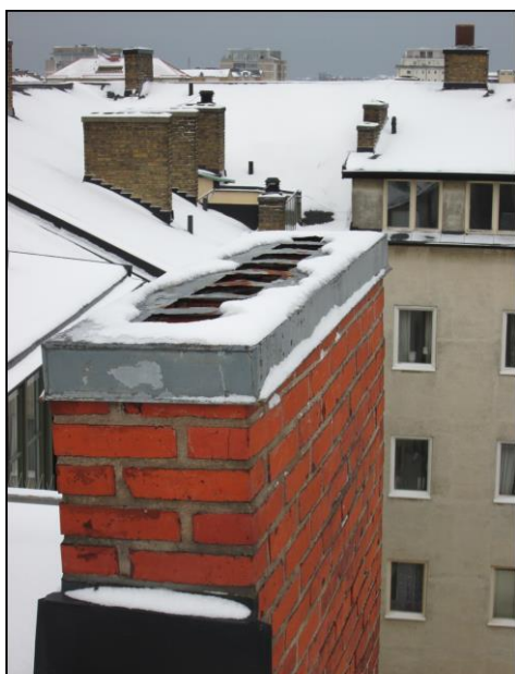
Skorstenar med plåtade kronor
